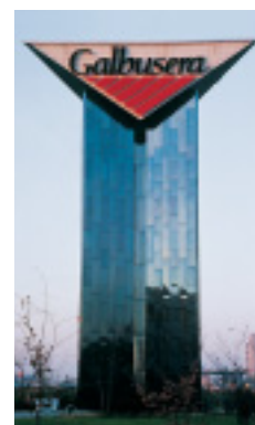
Konditorialiikkeen logoa kannattava 22 m korkea torni on verhoiltu elektrolyttisesti värjättyllä ruostumattomalla teräksellä.
